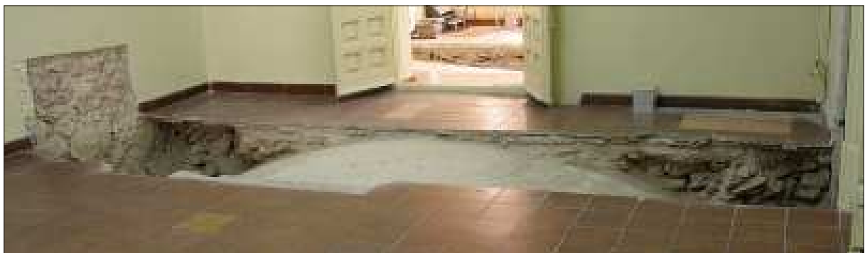
Volta descoberta en el decurs dels treballs a l'àmbit 107, datades del darrer quart del segle XIX.
